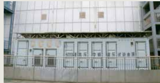
设备名称：高压变频调压试验电源 额定容量：6000kW 额定电压：10kV 额定电流：600A 输出频率：0 ~ 150Hz
